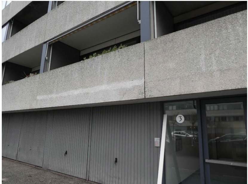
Repareret brystningselement, meget synlig reparation.
